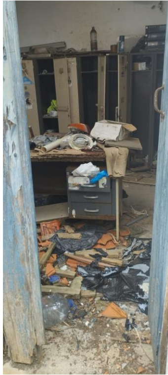
Figura 2 – Vista interior de compartimento
