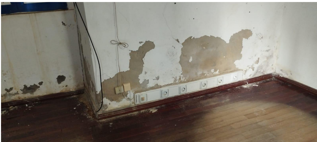
Figura 4 – Vista interior de compartimento
