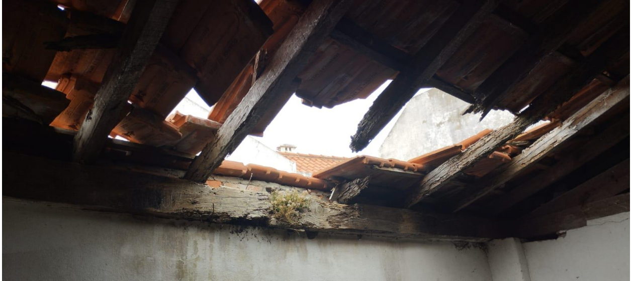
Figura 5 – Vista dos elementos estruturais da cobertura
